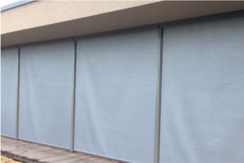
**Bild 9.4.6 V-förmige Wellen**
